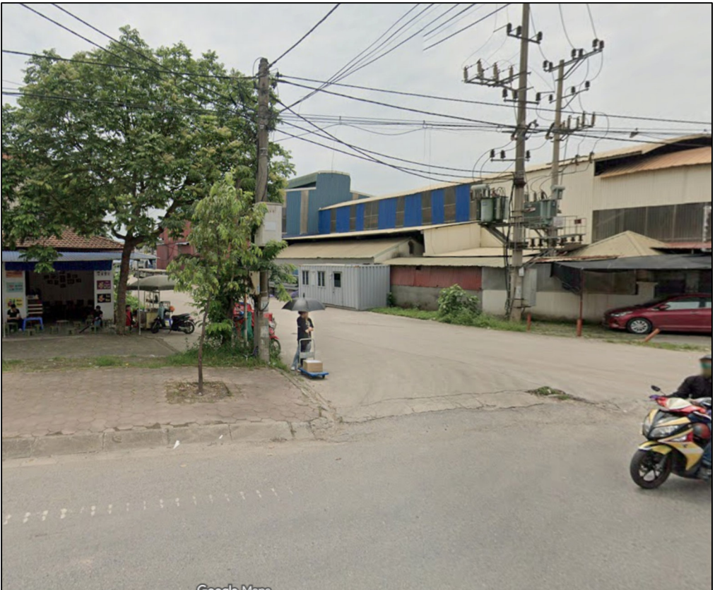
TRẠM BIẾN ÁP NGUYỄN GON
