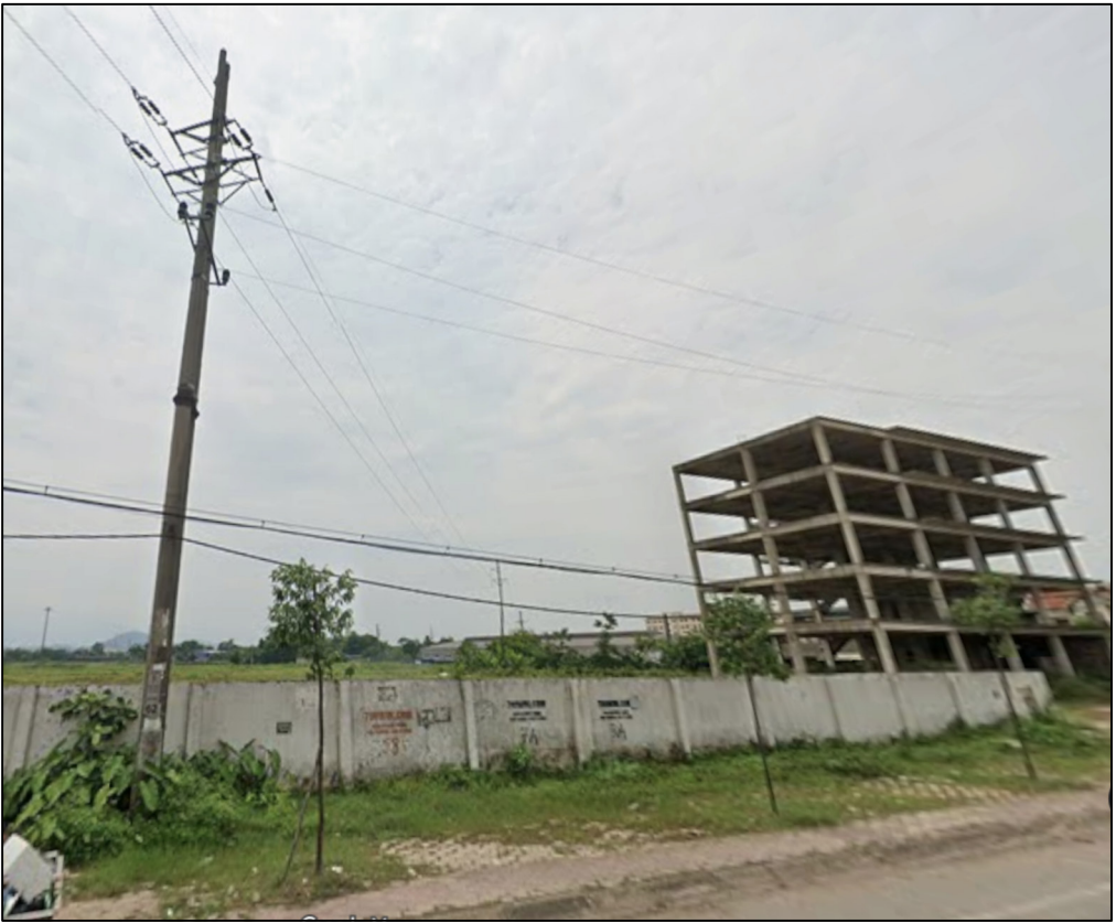
ĐƯỜNG DÂY 35KV
